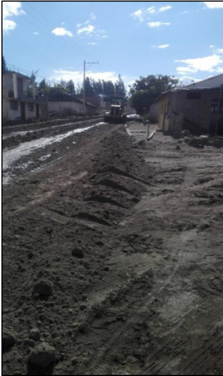
Colocación de base en la Calle 15 de Enero
