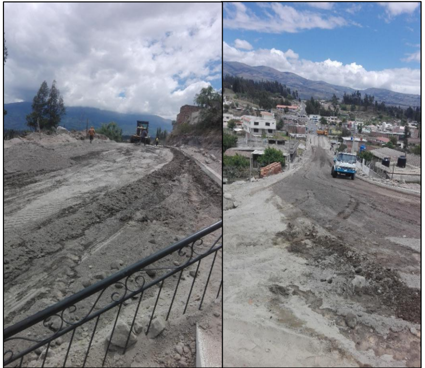
Colocación de base en la Calle 24 de Mayo.
